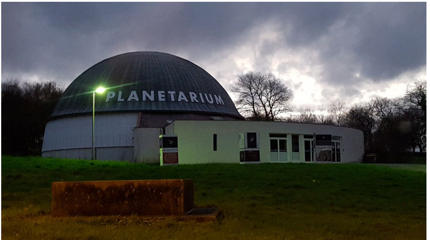
MOROJU AJEE & JO JEMORYE, Maison de l'observation des Failles, réplique d'un bâtiment existant (Pleumeur-Bodou) (2020).
