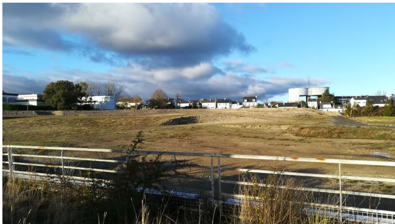
le bâtiment 89 et vue du site
